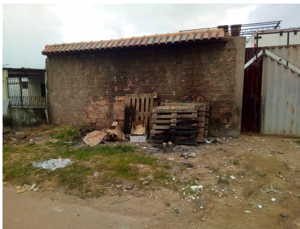
Figura 19 – Descarte ilegal de RCC
