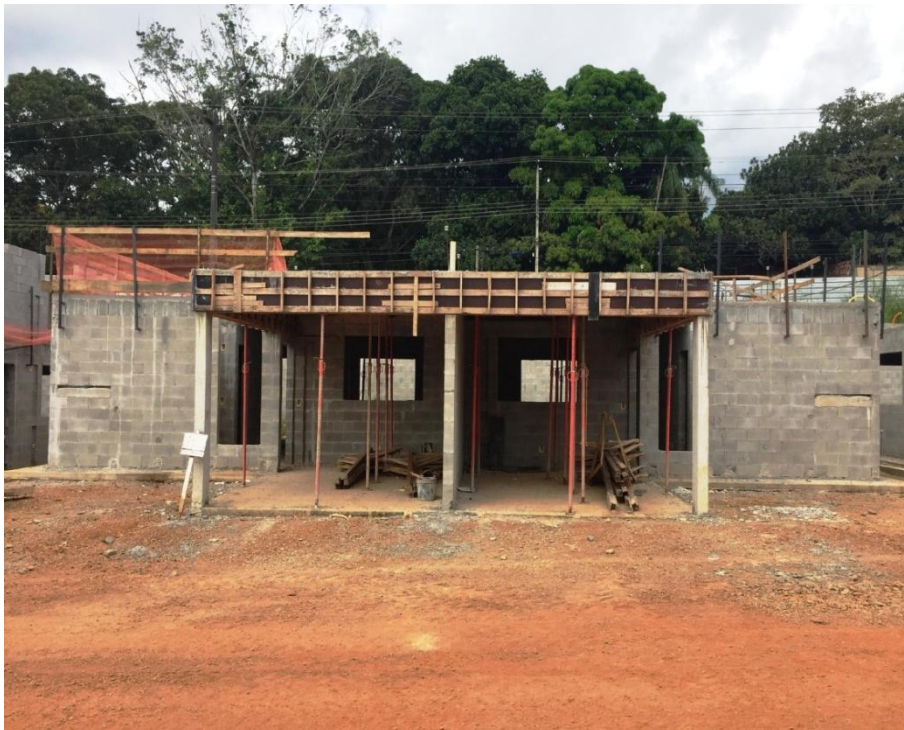
Figura 5: Casas geminadas Residencial Volpi 2 com aproximadamente 20% de conclusão da obra.
