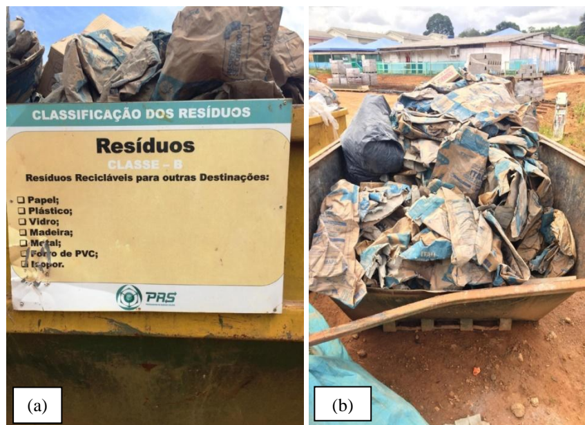
Figura 7: (a) Placa indicativa de classificação resíduos Classe B e (b) Resíduos Classe B.
