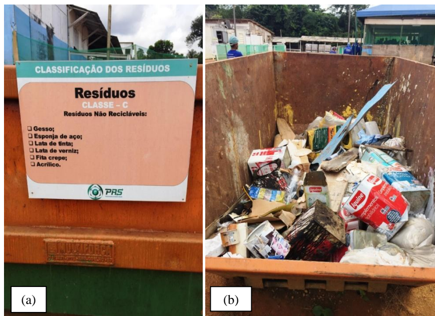
Figura 8: (a) Placa indicativa de classificação de resíduos Classe C e (b) Resíduos Classe C.
