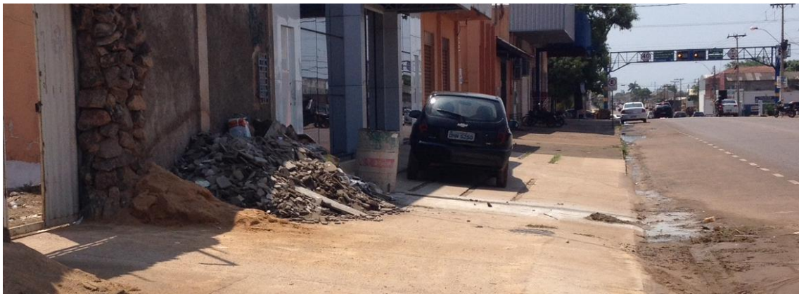
Figura 3 – RCD depositado em calçada.
