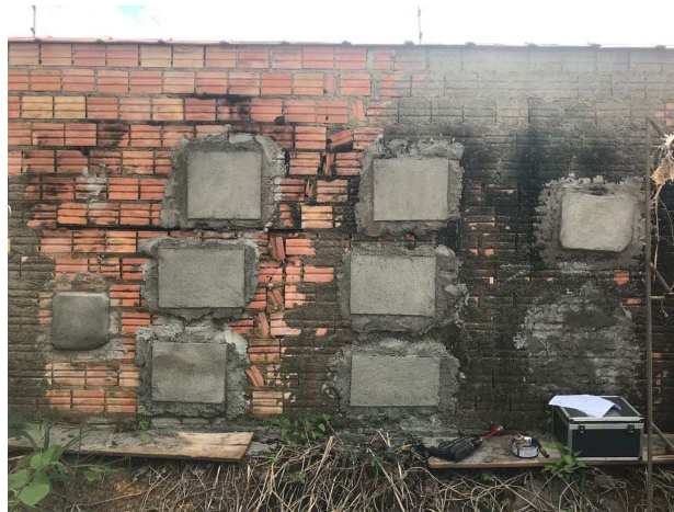
Figura 6 – Painéis de argamassas para ensaio de arrancamento.
